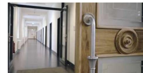
Die Originaltüren entsprechen nicht mehr dem Brandschutz, blieben aber erhalten. Die Sicherheit wird durch den neuen, versetzt dahinterliegenden Durchgang gewährleistet.
