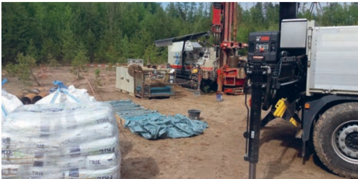
Bohrungen auf dem Haldenplateau mit Kerngewinnung
