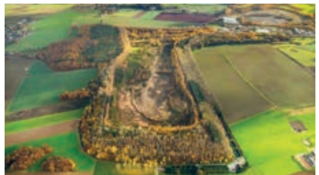
Luftaufnahme von der Bergehalde Beythal
