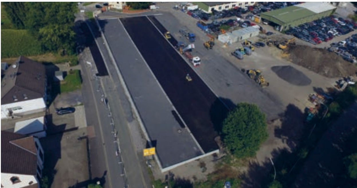
Wiederhergestellte Fläche nach Rückbau und Bodensanierung
