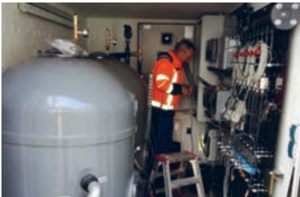
Blick in die Sanierungsanlage (im Aufbau), links die beiden Aktivkohlefilter zur Entfernung der LCKW, rechts die Zuläufe aus den Sanierungsbrunnen
