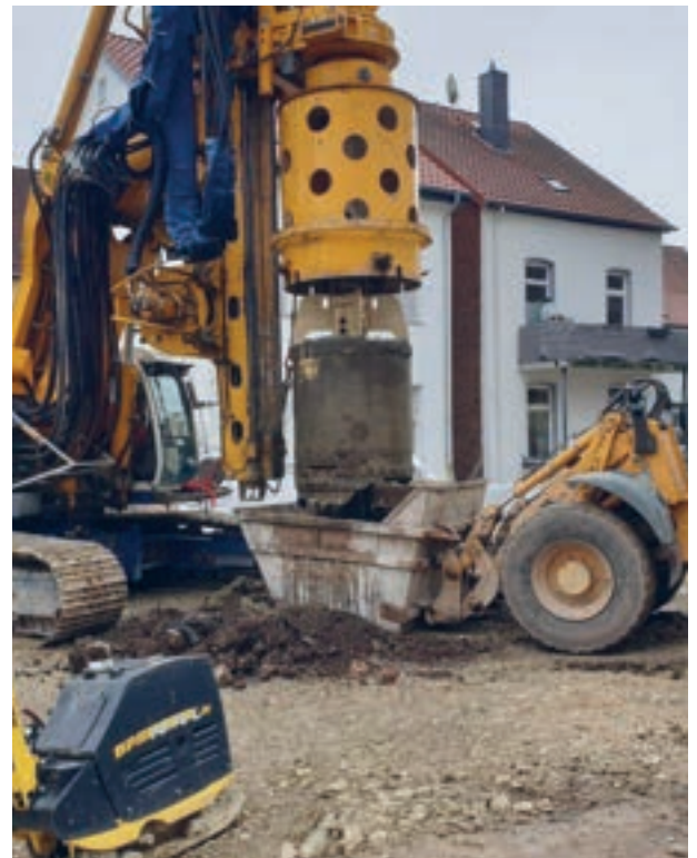
Bodenaustausch im Großlochbohrverfahren
