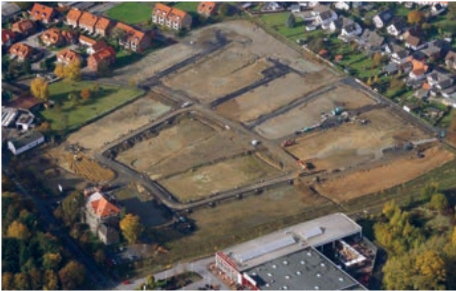
Das Gelände nach der Sanierung
