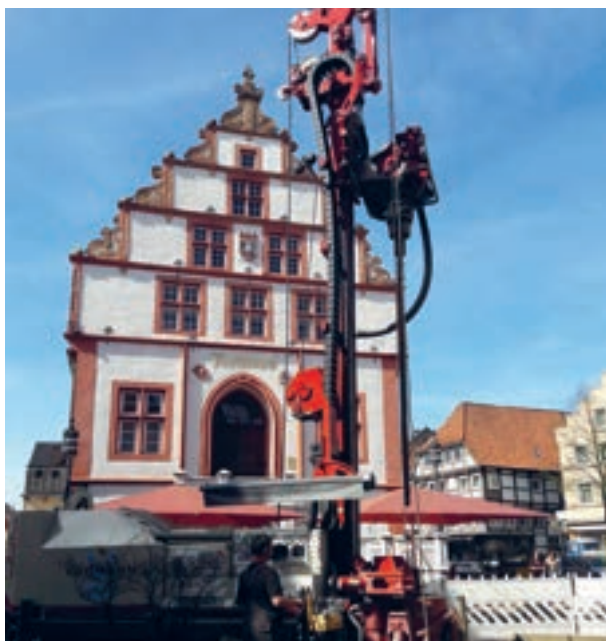
Bohrung zur Niederbringung einer der fünf Sanierungsbrunnen in Bad Salzuflen im Jahr 2018
