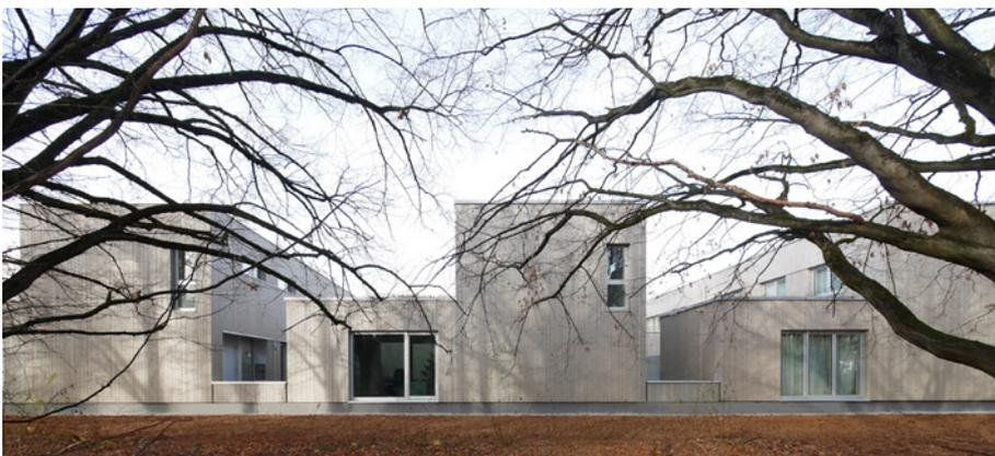
Auf den Untergeschossen und der Tiefgarage wurden beide Baukörperstypen oberhalb der Kellerdecke mit tragenden Außenwänden in Holzrahmenbauweise und Massivholzdecken aus Brettspertholz errichtet. Die Atriumhäuser sind der Gebäudeklasse 2 zugeordnet und ließen sich ohne Abweichung vom Bauordnungsrecht in feuerhemmender Holzbauweise realisieren.
