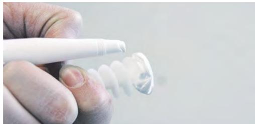
3 Fugen-Klebedichtmasse unter Dübelteller auftragen
