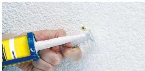
2 Fugen-Klebedichtmasse zur Abdichtung verwenden
