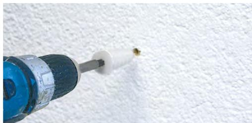
4 Spiraldübel oberflächenbündig mit verputzter Holzfaser-Dämmstoffplatte eindrehen
