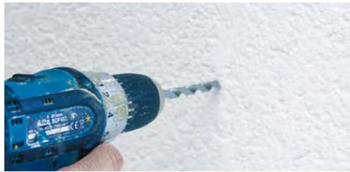
1 Verputzte Holzfaser-Dämmstoffplatte mit 8 mm-Holzbohrer vorbohren
