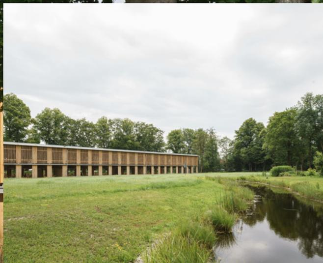
frei einsehbar ist, während das obere Deck mit senkrecht versetzten Lamellen versehen wurde, die wie ein transluzenter Vorhang wirken. Dieses Detail erhöht auch die gefühlte Sicherheit der Nutzer, die sich in keinem Bereich des Parkhauses in einem geschlossenen Raum wähen. Das Parkhaus bietet Platz für bis zu 104 Autos.
