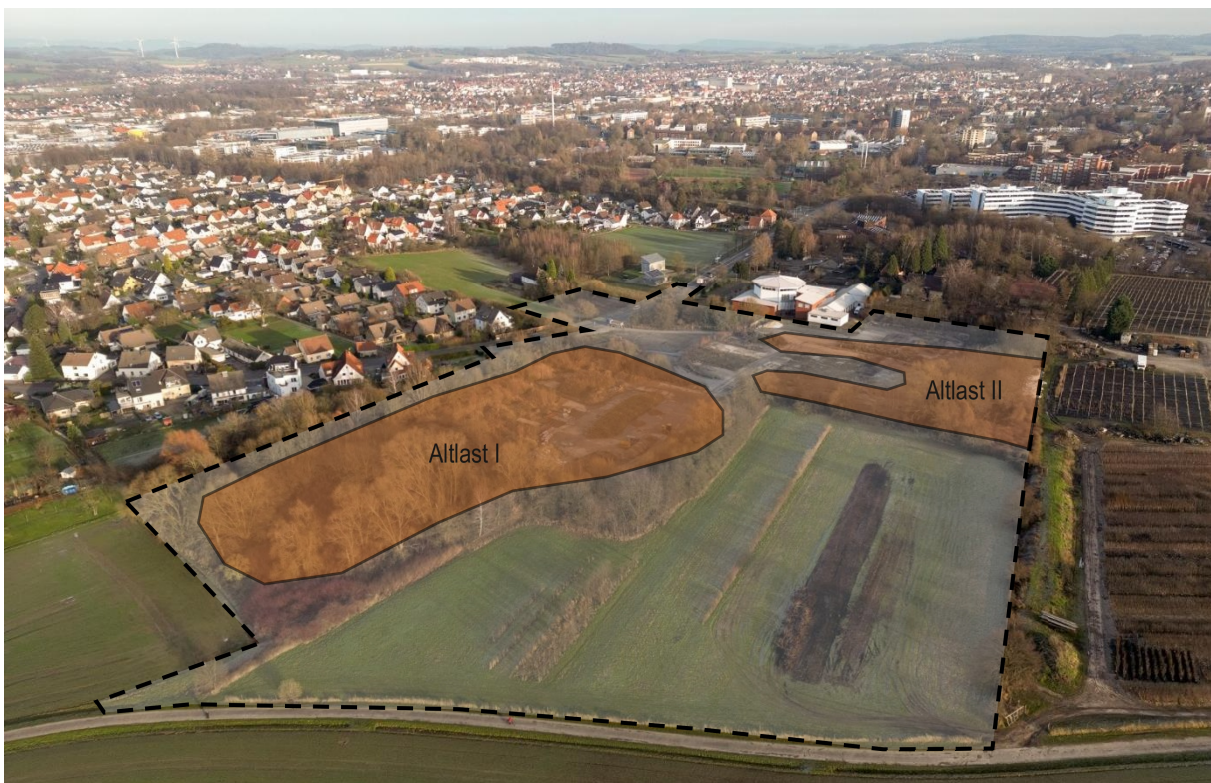
Luftbildaufnahme des Plangebietes mit grober Abgrenzung der Altlastbereiche; im Hintergrund die Detmolder Innenstadt Quelle: Stadt Detmold
